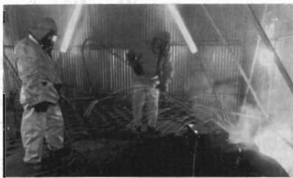
WAGR におけるサーマル・ランサーによる 上部生体しゃへい体の解体
