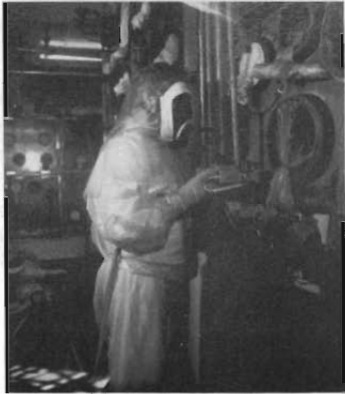
BNFL 燃料製造におけるせん断機による 解体作業
